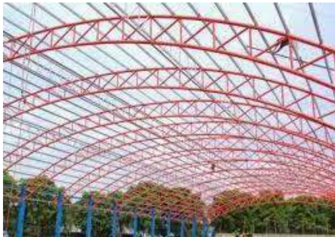
Gambar 4.42 Rangka pipa baja
